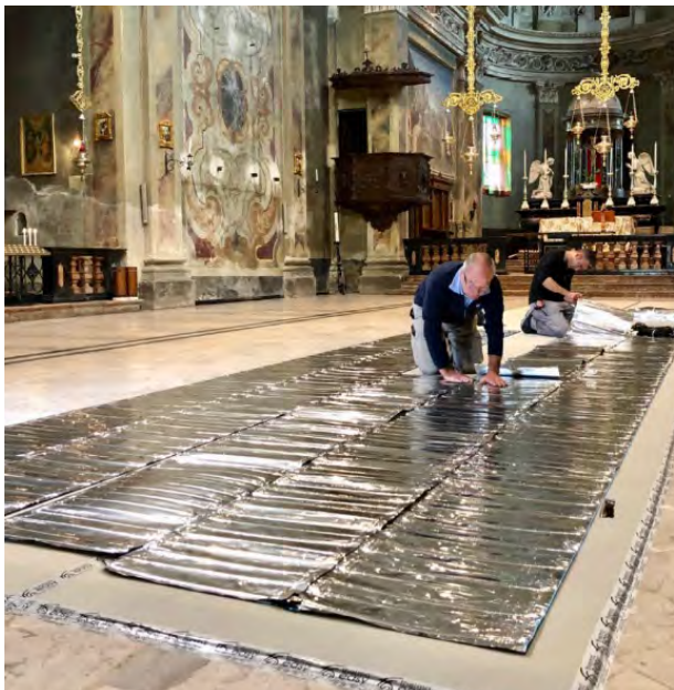
INSTALLAZIONE DEL RADIANTE WARMSET SOPRA ALL'ISOLANTE
