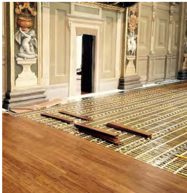
POSA DEL RADIANTE WARMSET SOPRA ALL'ISOLANTE
