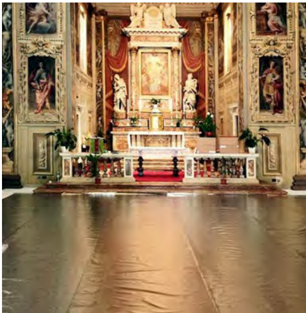
INSTALLAZIONE DELL'ISOLANTE WARMDUPLEX FOAM
