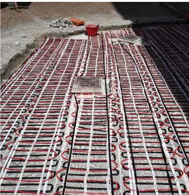
RISCALDAMENTO INSTALLATO SOTTO AI SANPIETRINI
